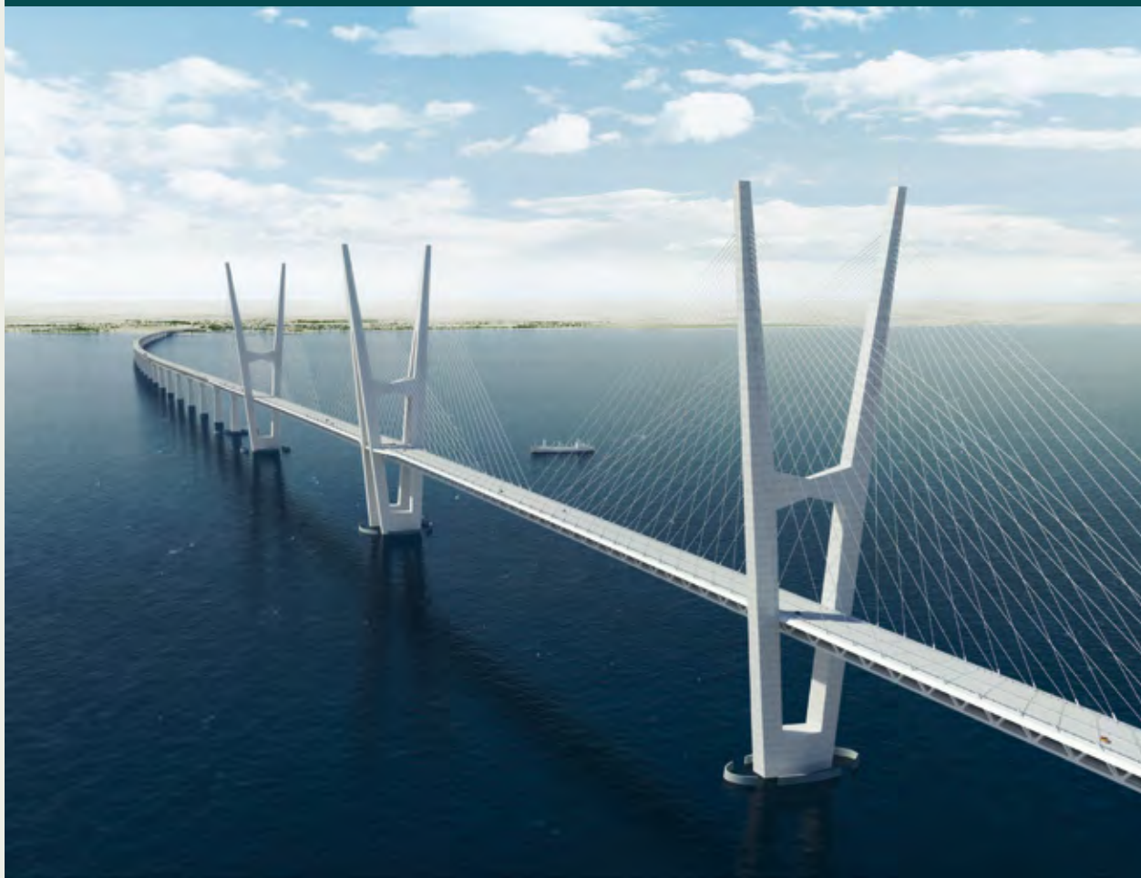
FIGUR 12.3 Principkitse af en skråstagsbro over Femern Bælt
