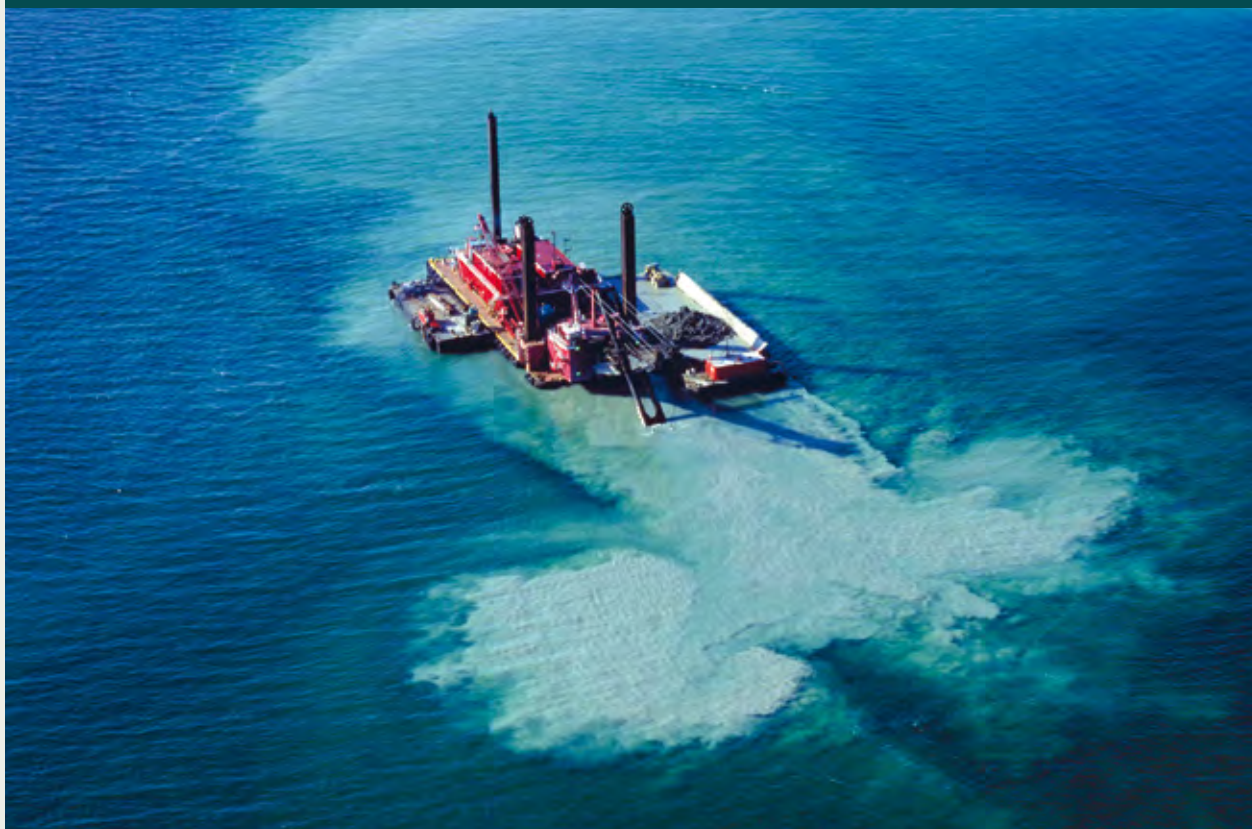
FIGUR 14.1 Foto af gravearbejder fra anlægsfasen af Øresundsforbindelsen
